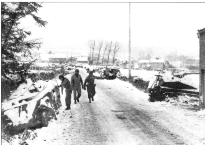
Подбитые Тэск Форс Орт из 3-й бронетанковой дивизии армии США полугусеничные бронетранспортеры Sd.Kfz. 250 116-й панцердивизии. Две машины слева – бронетран- спортеры серии «Неице», справа – «Алте». Необычна 20-мм автоматическая пушка на бронетранспортере.
