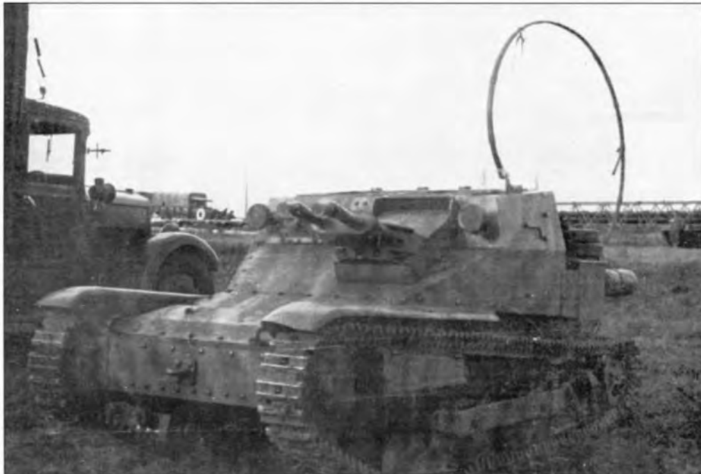
Танкетка CV3/33 2-й серии с радиостанцией
