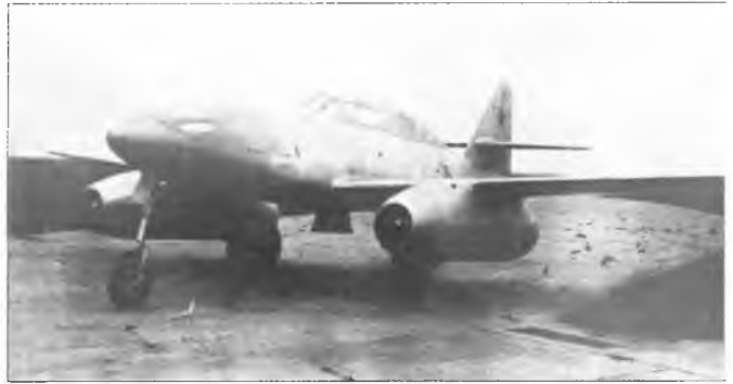
Двухместный Me 262B-2 проходил специальные летные испытания в НИИ ВВС в варианте учебного истребителя без использования бортовой локационной установки. Сентябрь 1946 г.
